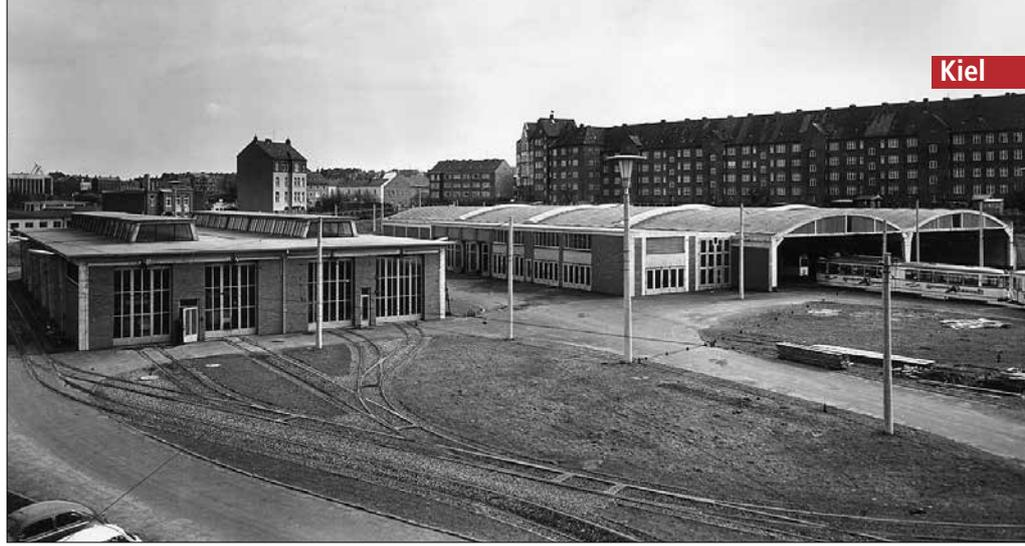
Der moderne, neu gebaute Betriebshof Gaarden mit (v. l. n. r.) zwei Durchfahrtsgleisen für Wasch- und Revisionsarbeiten, zwei Werkstattgleisen und der Radsatzschleifanlage neben der großen zweiteiligen Abstellhalle mit 14 Gleisen
